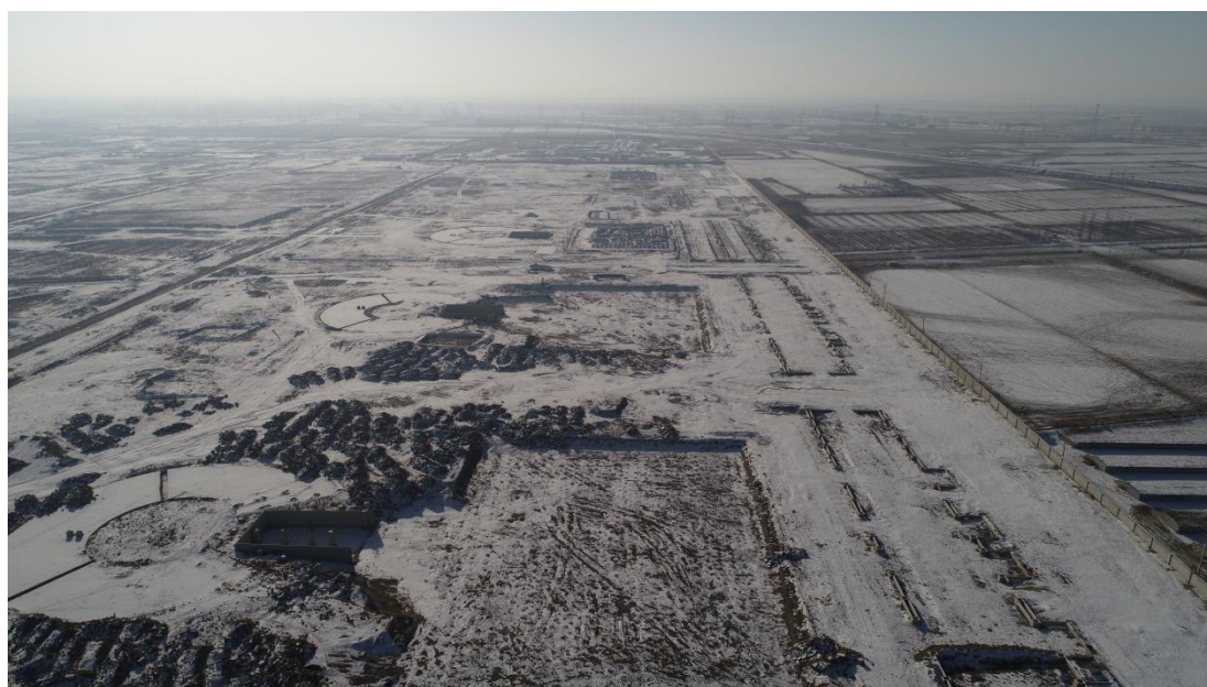
九原工业园区新材料产业园区现场照片
